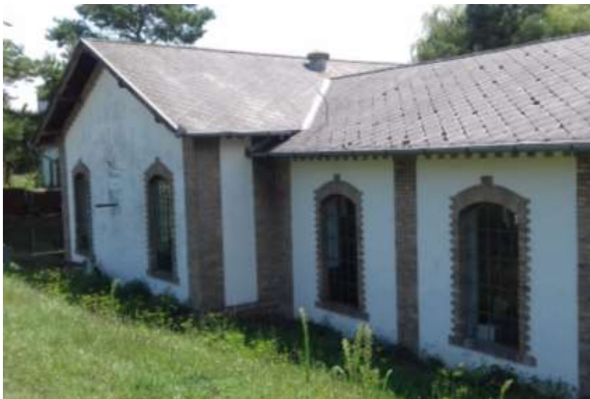
Dózsamajor régi szivattyúház (0160/1 hrsz)
